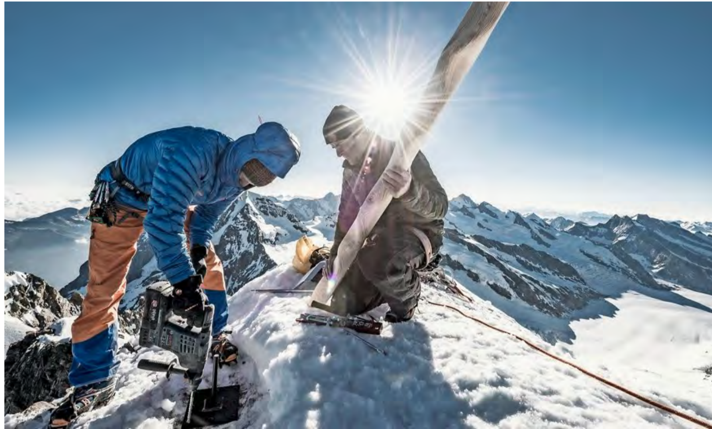
Bergführer und «Bauleiter» Stephan Siegrist (l.) bohrt auf dem Gipfel der Jungfrau (4158 m) eine Verankerung – Dominic Müller hält eine der Eschenholz-Skulpturen bereit. Im Hintergrund rechts unten ist der Aletschgletscher zu sehen.
